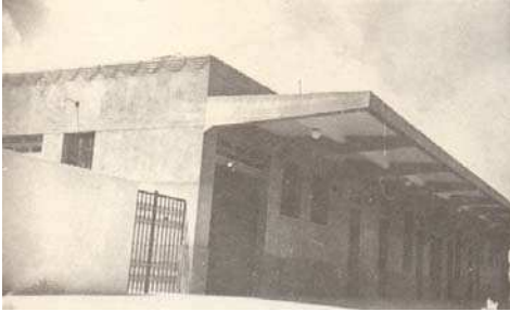
Figura 3.18 VISÃO LATERAL DA ESTAÇÃO DA LESTE
