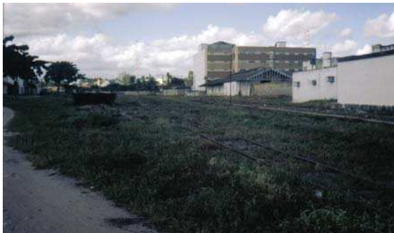
Figura 4.2 ESTADO DE CONSERVAÇÃO DOS TRILHOS, AO FUNDO - ESTAÇÃO DE ALAGOINHAS E NA LATERAL DIREITA - FUNDOS DA ESTAÇÃO DA LESTE, HOJE SECRETÁRIA DE SAÚDE DE ALAGOINHAS.
