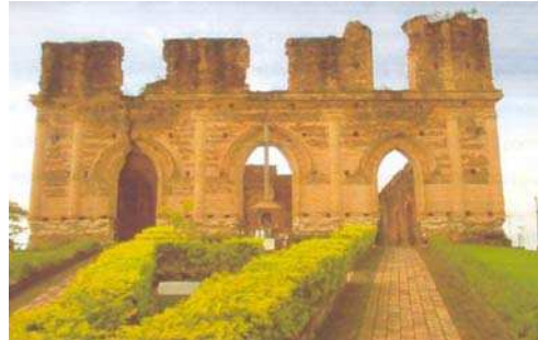
Figura 2.2 RUÍNAS DA IGREJA DE ALAGOINHAS VELHA
