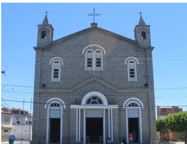
Figura 3: Igreja Matriz, Paroquia de Santa Luzia-Santaluz-Ba. Fonte: De autoria própria
