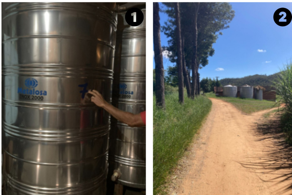
(1) Reservatório de cachaça/ Área interna (2) Reservatório de cachaça/ Área externa
