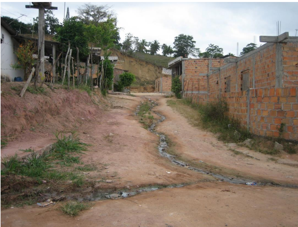
Figura 4.6 – Esgoto a céu aberto em Pitanguinha
