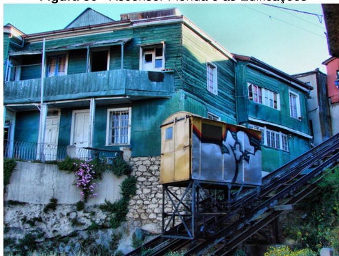
Figura 30 - Ascensor Florida e as Edificações
