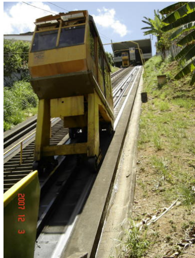
Figura 9 - Plano Inclinado Liberdade - Calçada
