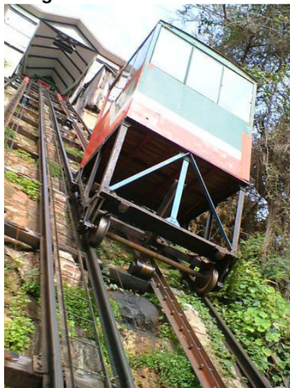
Figura 34 – Ascensor El Peral
