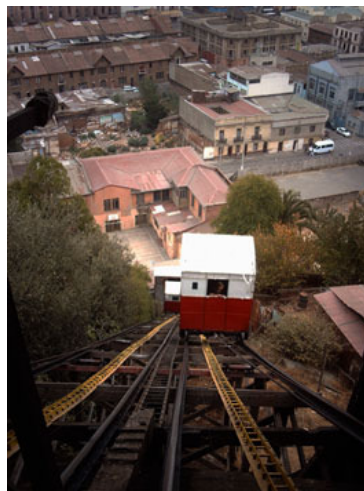
Figura 28 – Vista de Cima do Ascensor Larraín
