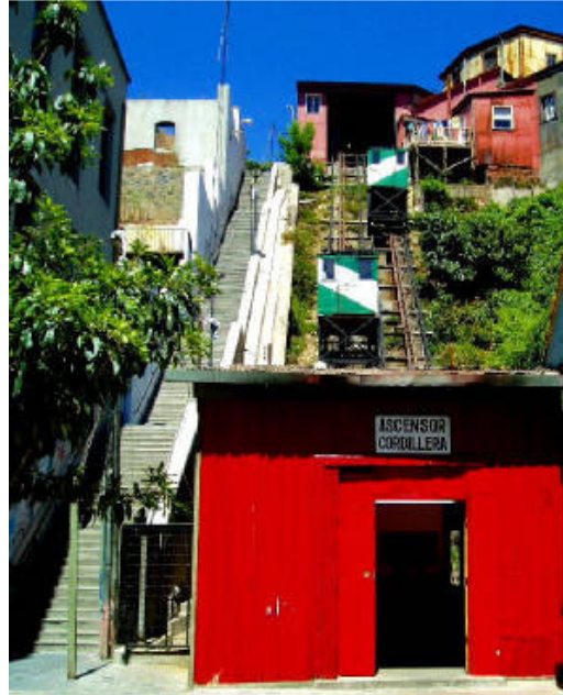
Figura 27 – Sobe e Desce do Ascensor Cordillera
