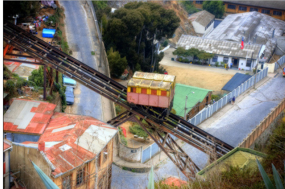
Figura 35 – Ascensor Villaseca Sobre as Vias
