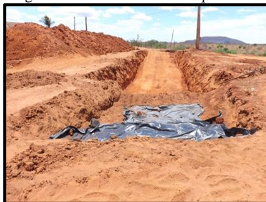
Figura 20 – Fechamento de quadrículas após a escavação
