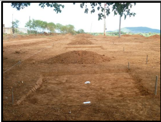
Figura 11 – Início da escavação
