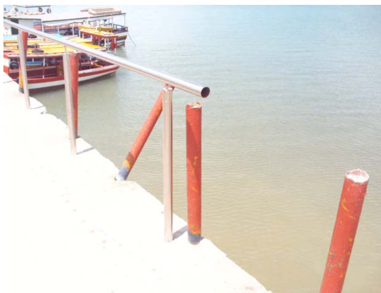
FOTOGRAFIA 15: Guarda corpo antigo e novo Fonte: Silva, 2010
