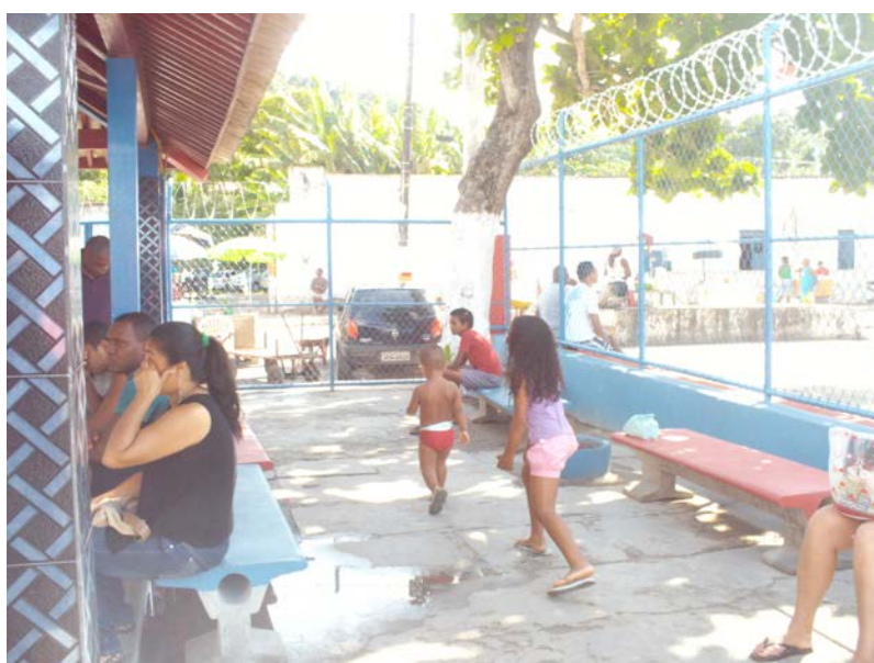
FOTOGRAFIA 17: Alambrado do Terminal Marítimo após a reforma Fonte: Silva, 2011
