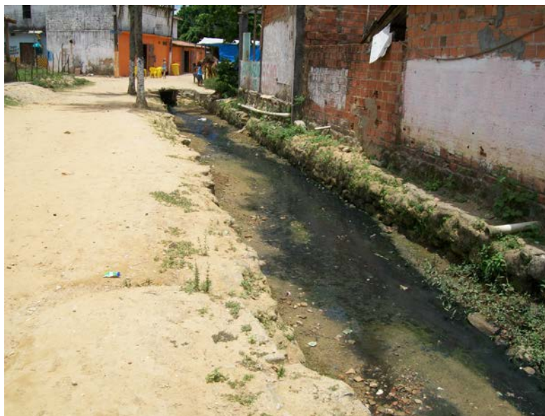
FOTOGRAFIA 4: Esgoto a céu aberto em Santana Fonte: Silva, 2010
