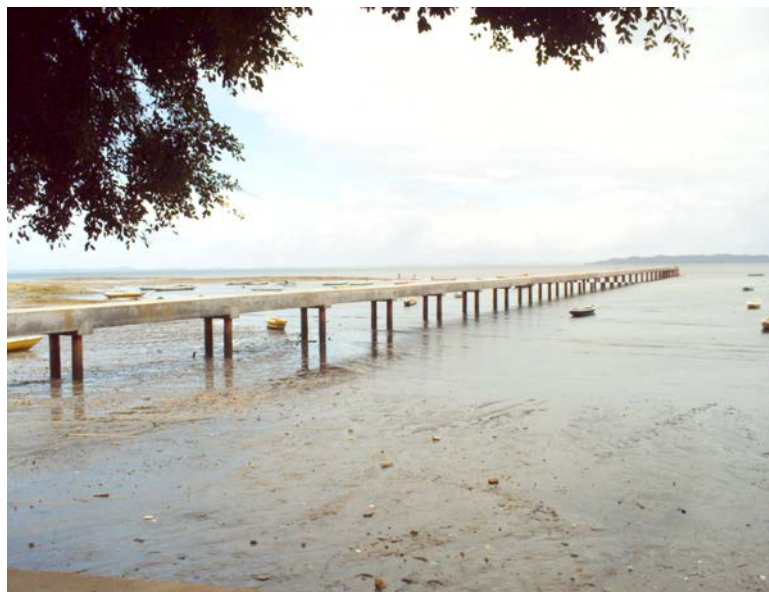
FOTOGRAFIA 21: Ponte em construção em Santana Fonte: Silva, 2010
