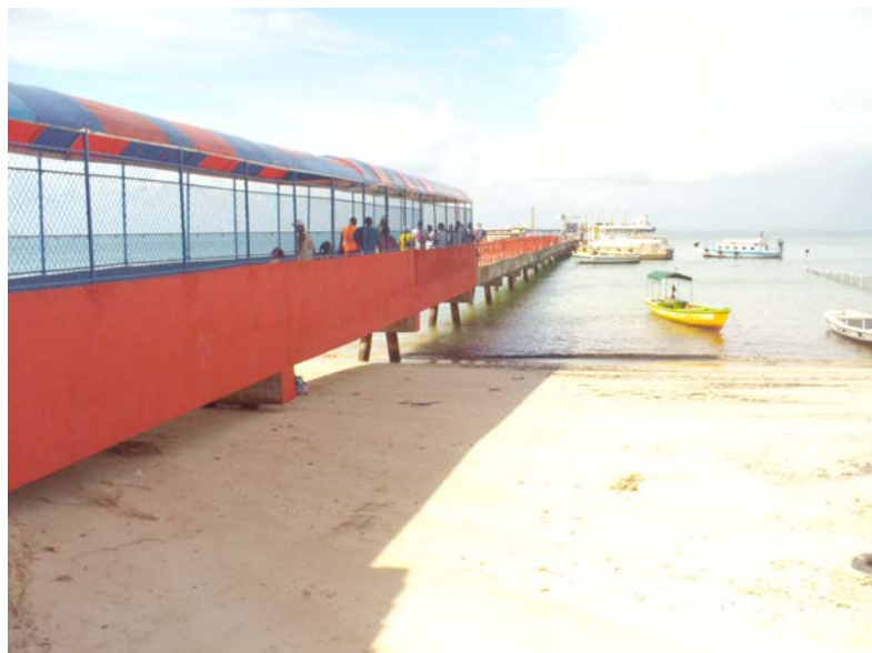
FOTOGRAFIA 16: Toldo do Terminal Marítimo após a reforma Fonte: Silva, 2011
