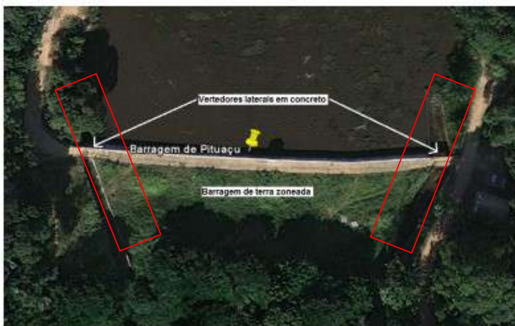
Figura 41: Zona de proteção do extravasor da Represa de Pituáçu
