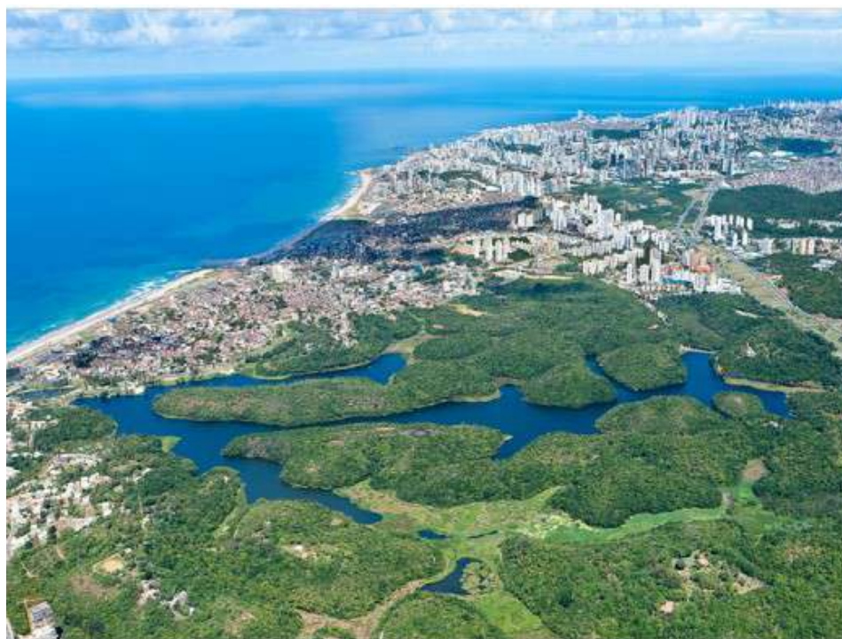
Figura 8: Reservatório de Pituaçu
