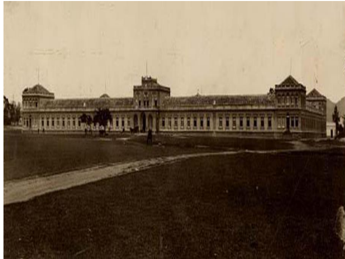
Figura 17: Colégio Militar de Porto Alegre-Rs fachada antiga Fonte:
