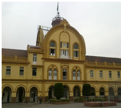
Figura 18: Colégio Militar de Porto Alegre-Rs fachada atual
