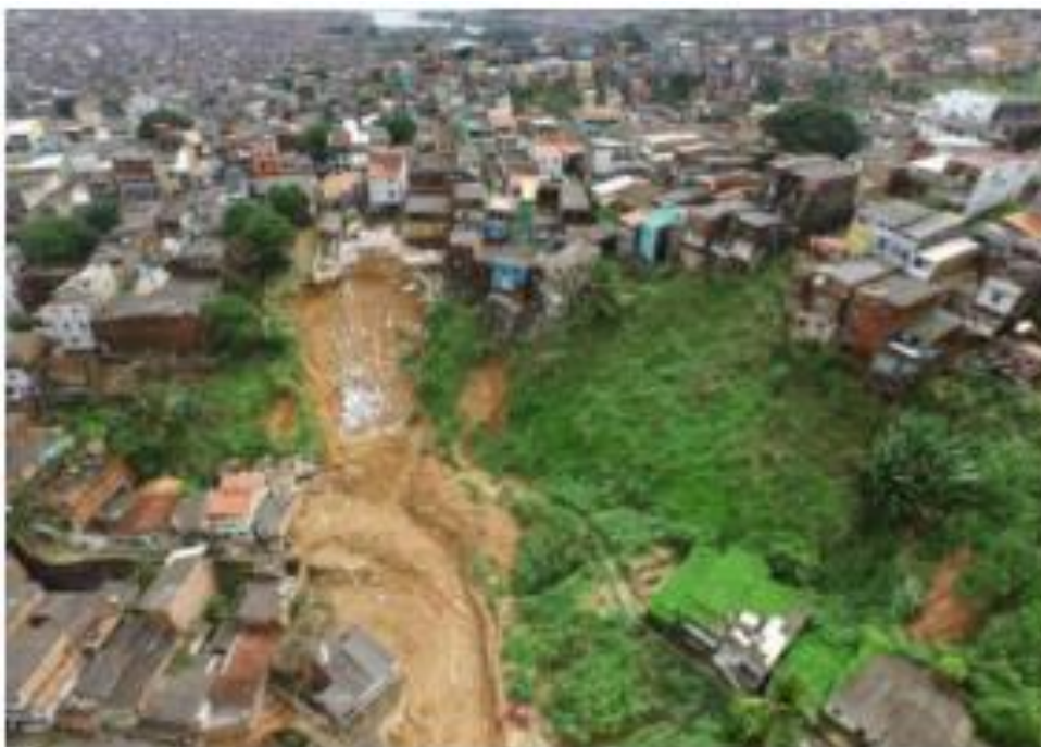
Foto 8- Deslizamento de terra no bairro do Barro Branco/Alto do Peru, 2015
