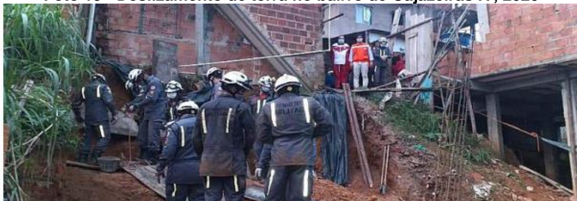
Foto 19 - Deslizamento de terra no bairro de Cajazeiras IV, 2020
