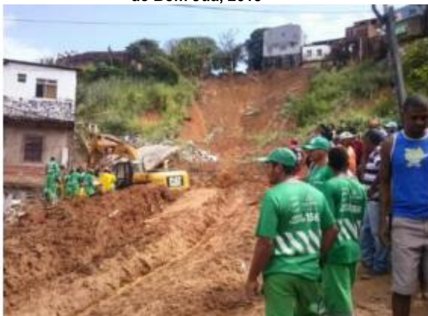
Foto 9- Deslizamento de terra no bairro de Bom Juá, 2015
