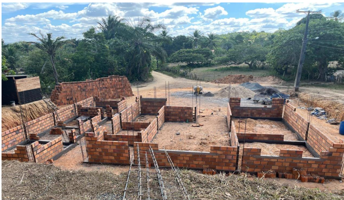
Figura 24 – Construção da Unidade de Produção Artesanal
