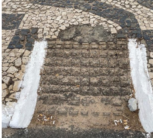
Figura 22: rampa de acesso.
