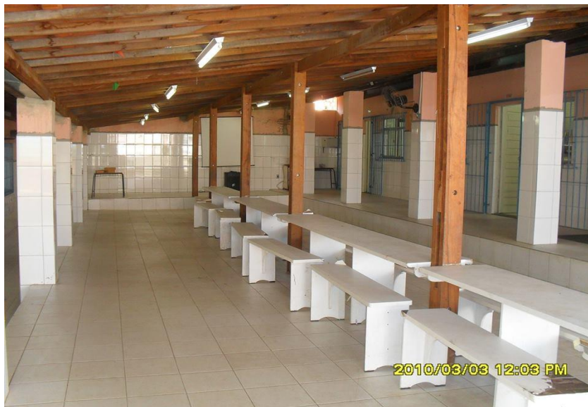
Figura 7 - Interior da escola (após a reforma)
