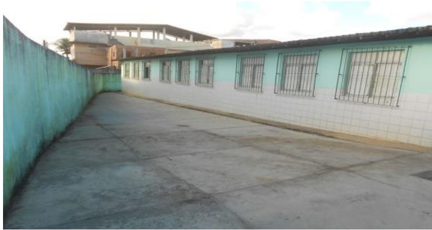
Figura 6 - Lateral interna da escola (antes da reforma)
