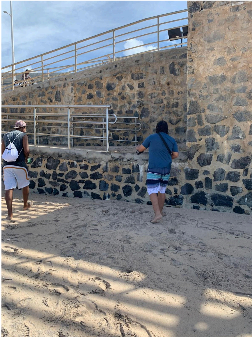
Figura 15 – Registro das Obras no Trecho Amaralina – Rampas de acesso na Av. Octávio Mangabeira nas proximidades da transversal com a Rua Pará, na Pituba
