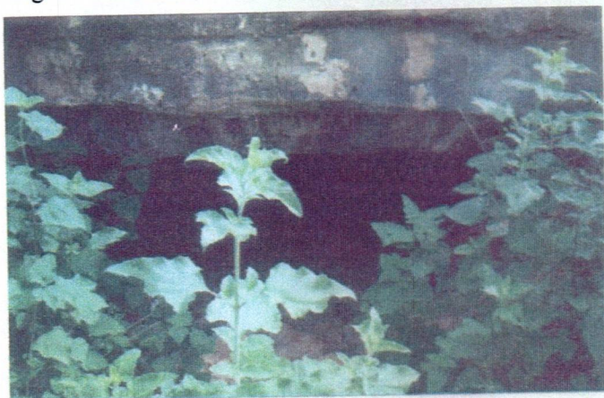
Fig. 5 – Entrada da Toca dos Ossos, vista exterior
