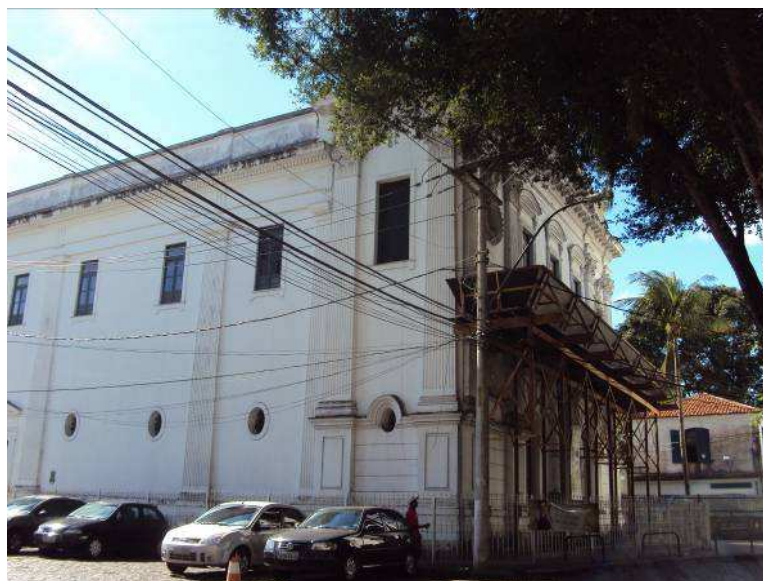
Figura 7 - Igreja da Vitória em reforma, 2011.
