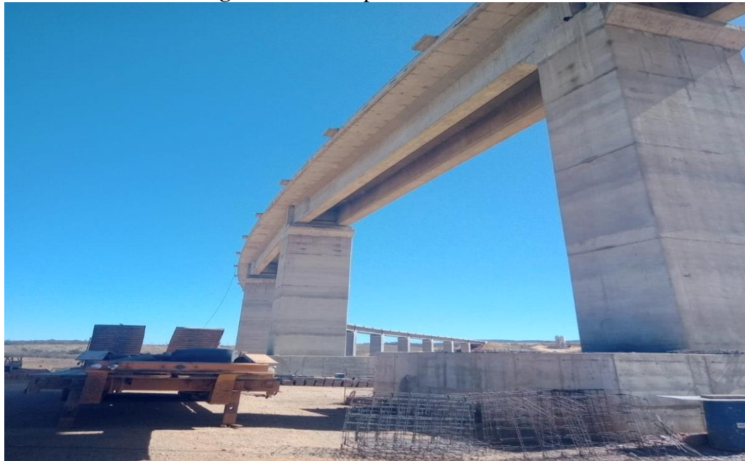
Figura 14: Ponte próxima ao canteiro
