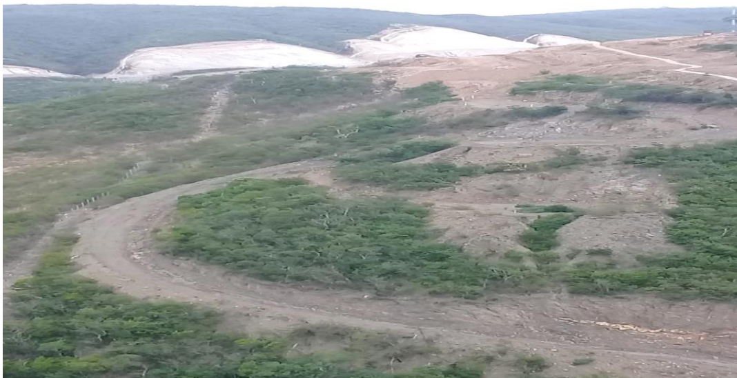
Figura 6: Trecho de obras construção de viadutos na localidade de Curral Velho: início da construção 2018.
