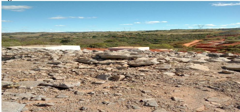
Figura 7: Obras de viaduto em andamento na localidade de Curral Velho.
