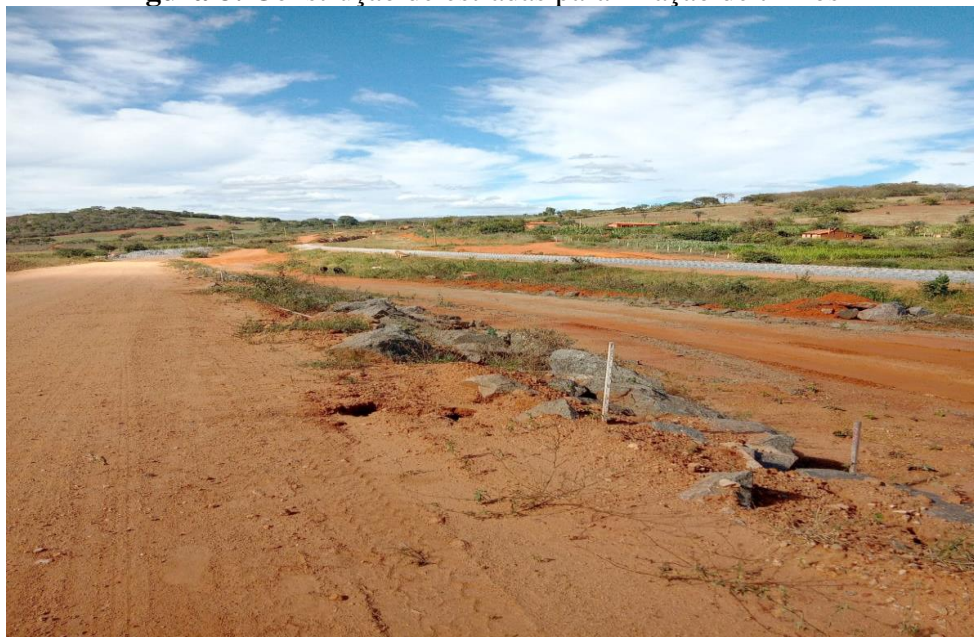
Figura 8: Construção de estradas para fixação de trilhos
