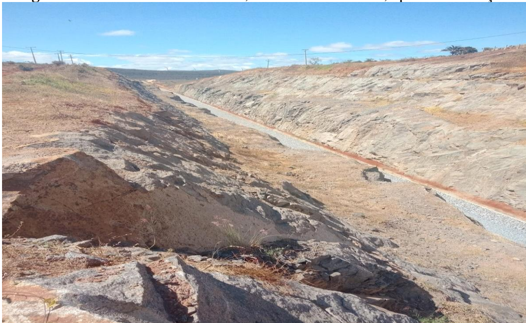
Figura 10: local de corte de morro, centro da localidade, após as detonações
