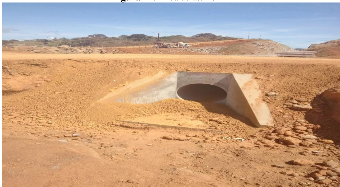
Figura 22: Área de aterro
