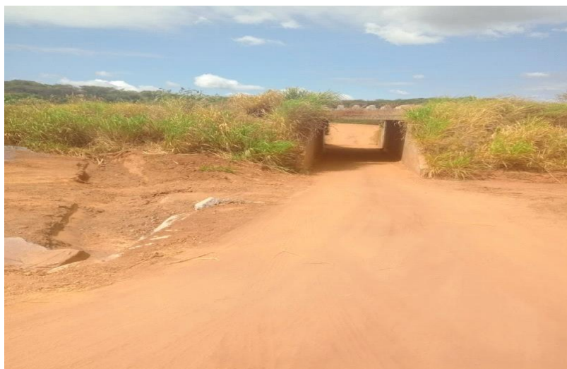
Figura 12: Túnel :trecho da localidade
