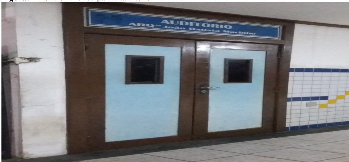
Figura 9 - Porta de entrada para o auditório
