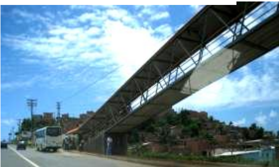
Figura 29 – Ponto próximo à passarela
