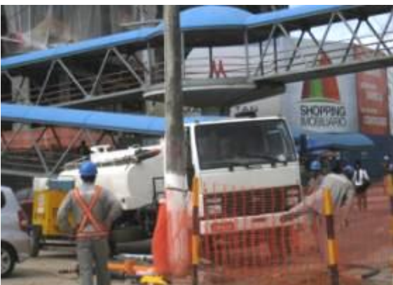
Figura 16 – Canteiro de obra I
