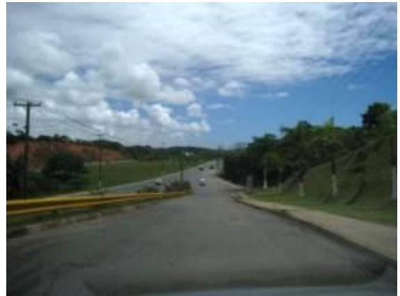
Figura 10 – Saída de Veículos FTC
