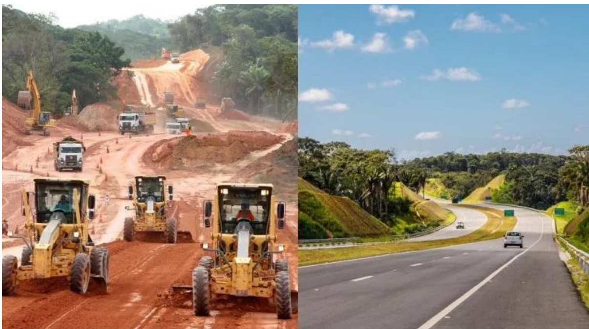
Figura 2 – Construção da BA-535 VMCLF (Via Metropolitana)
