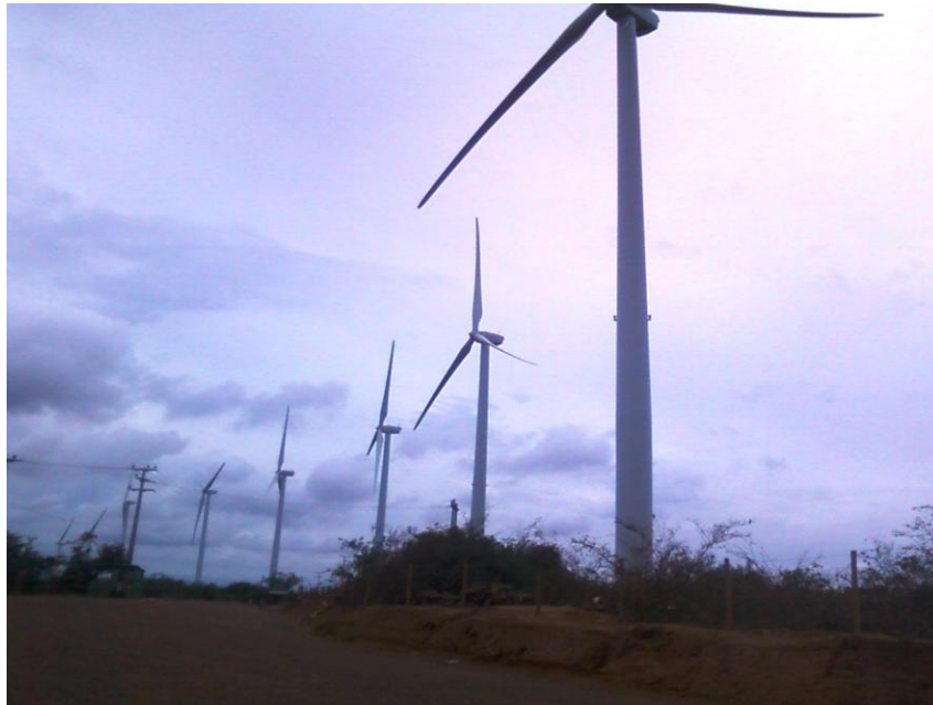
Figura 5: Parque eólico conectado à rede com aerogeradores de eixo horizontal – Parque Eólico Alto Sertão I- BA Fonte: Pesquisa de campo, 2013.
