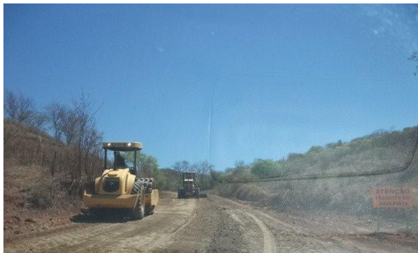
Figura 19: Estrada sendo alargada- Pindaí, BA.
