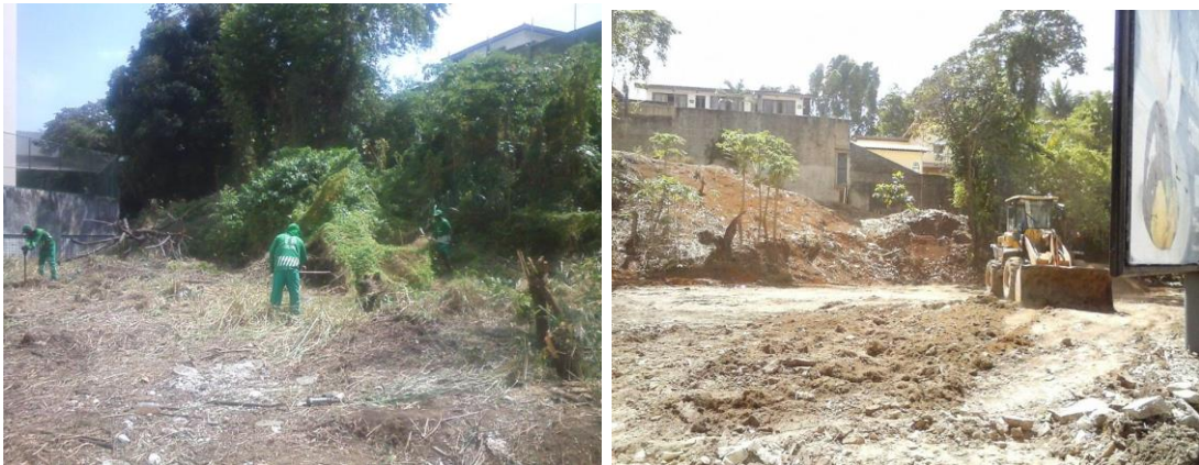
Figura 13 - Limpeza e preparação do terreno
