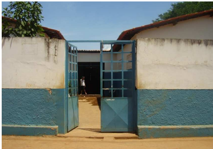
Foto 09 - Escola Dr. Abílio Farias – portão de entrada. (Abr, 2009).
