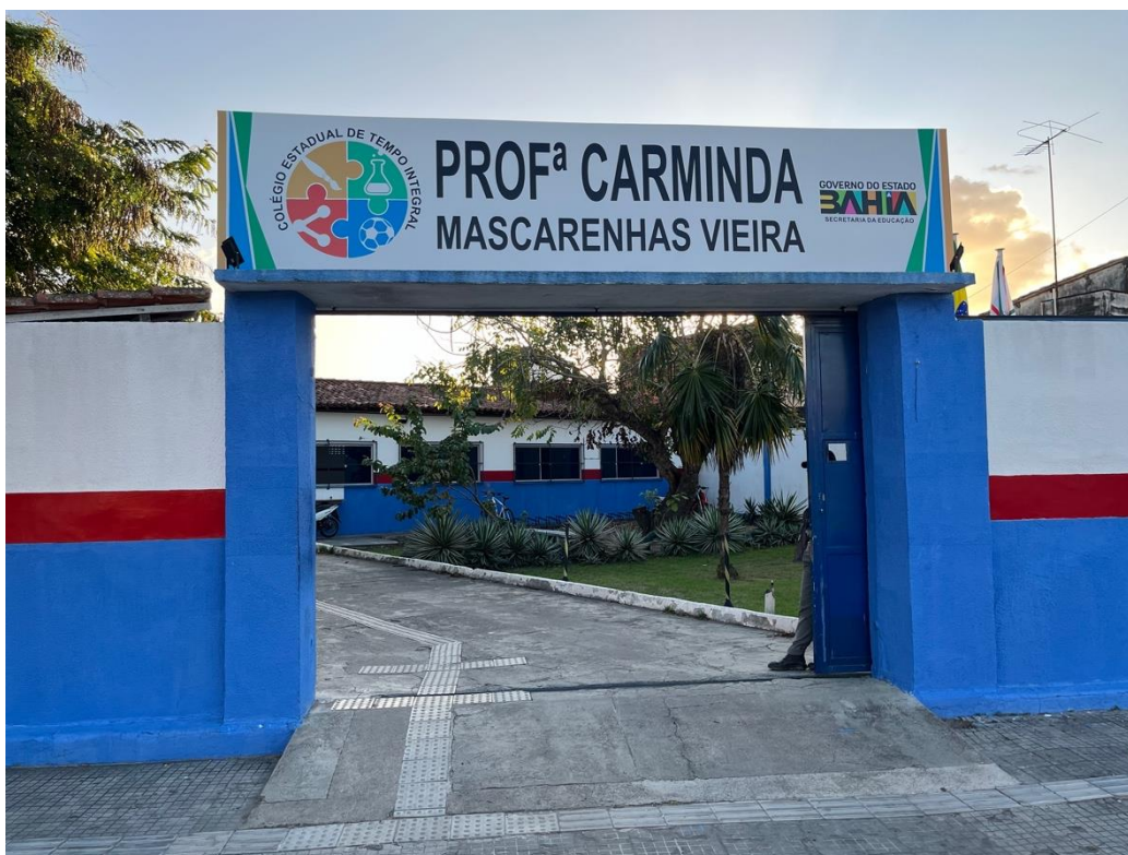
Foto 01 - Portão de entrada
