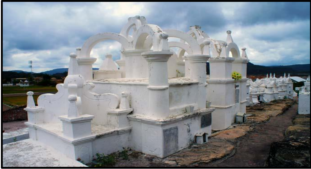
Figura 10 — “Túmulo Bizantino” do cemitério de Santa Isabel da cidade de Mucugê
