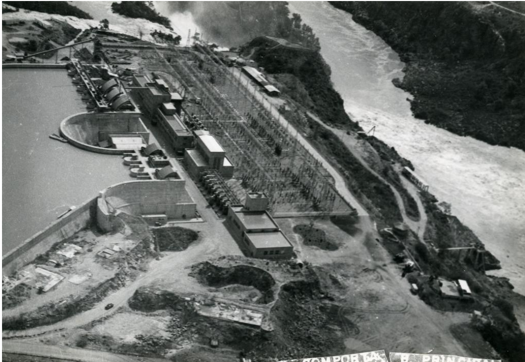
Figura 6: Vista do CHPA: Complexo Hidrelétrico de Paulo Afonso
