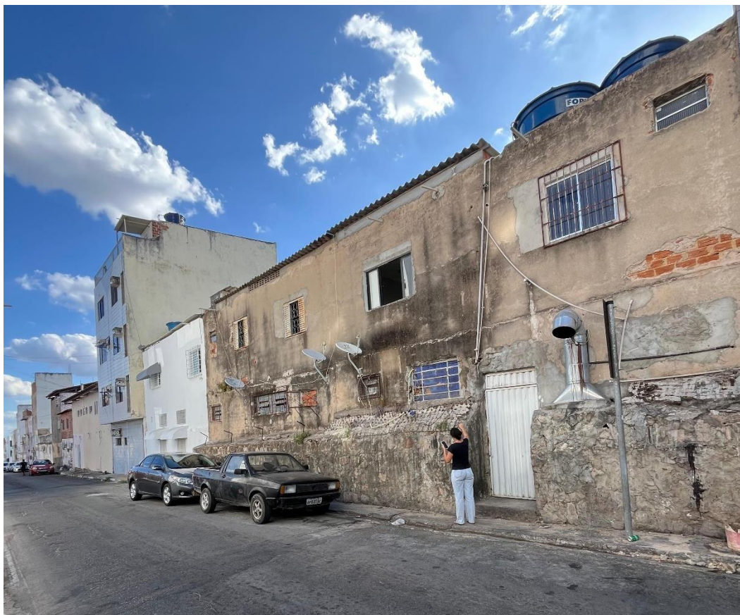
Figura 20: Realização do trabalho de identificação da estrutura
