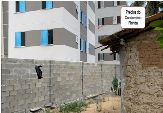
Figura 12 – Casa de morador e proximidade dos prédios do condomínio Flórida.
