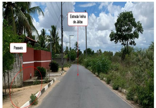
Figura 13 - Falta de calçada na Estrada Velha de Jaíba para os moradores.
