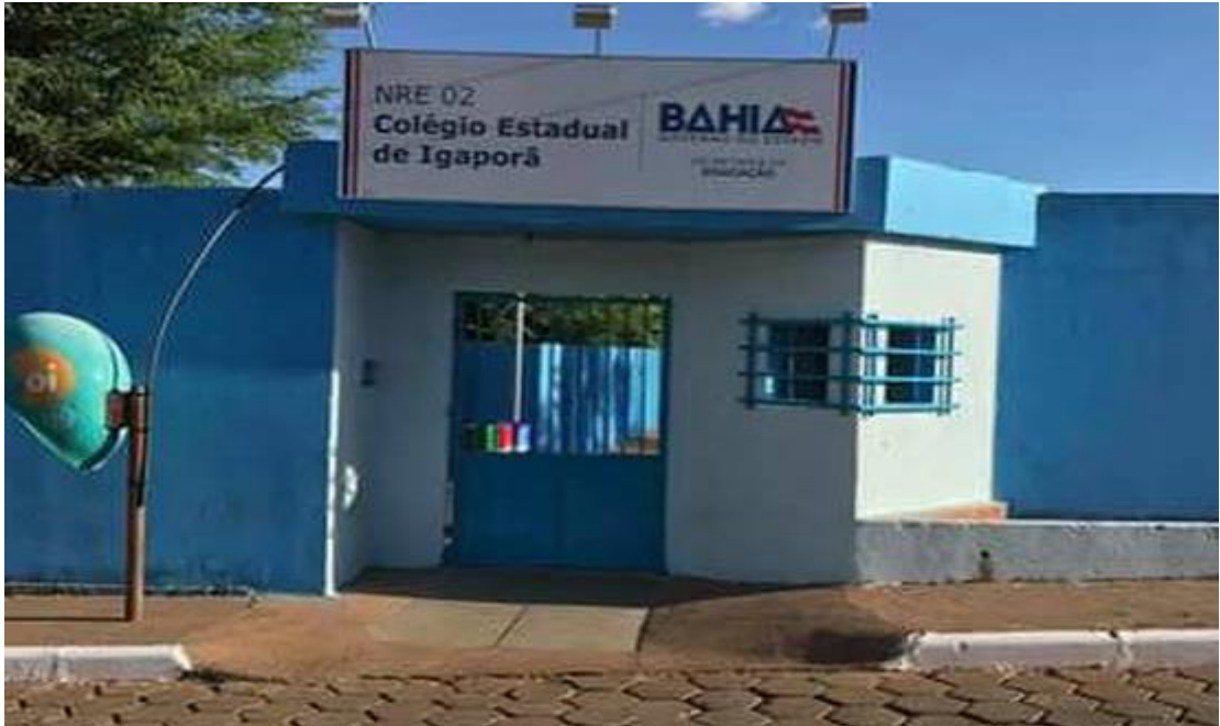
Imagem 1: Fachada do Colégio Estadual de Igaporã
