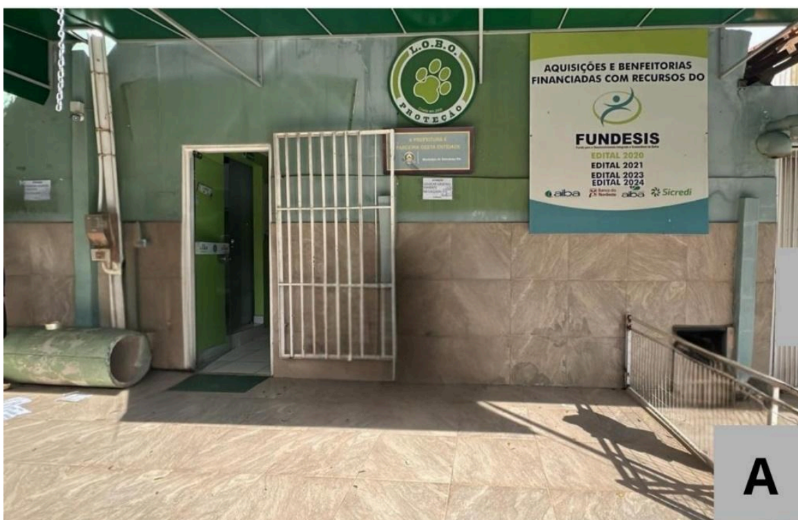
Figura 1 - Fachada da ONG LOBO
