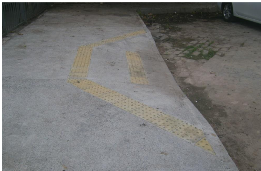
Figura 11 – Passeio de acesso a Igreja do Pilar
