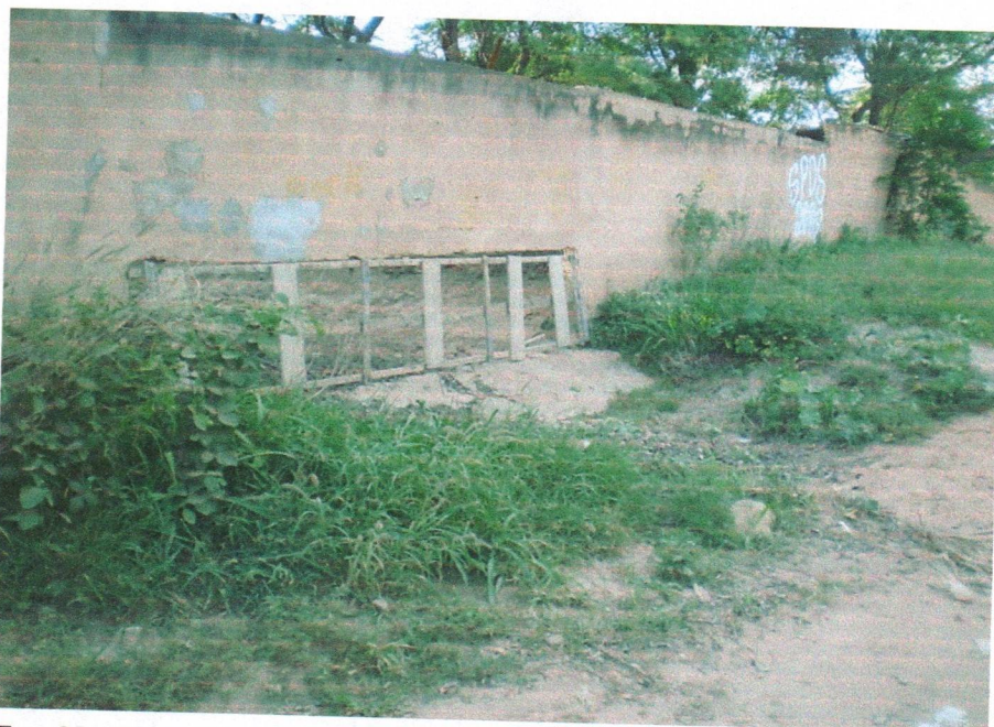
Foto 20 - Construção em área de preservação permanente
