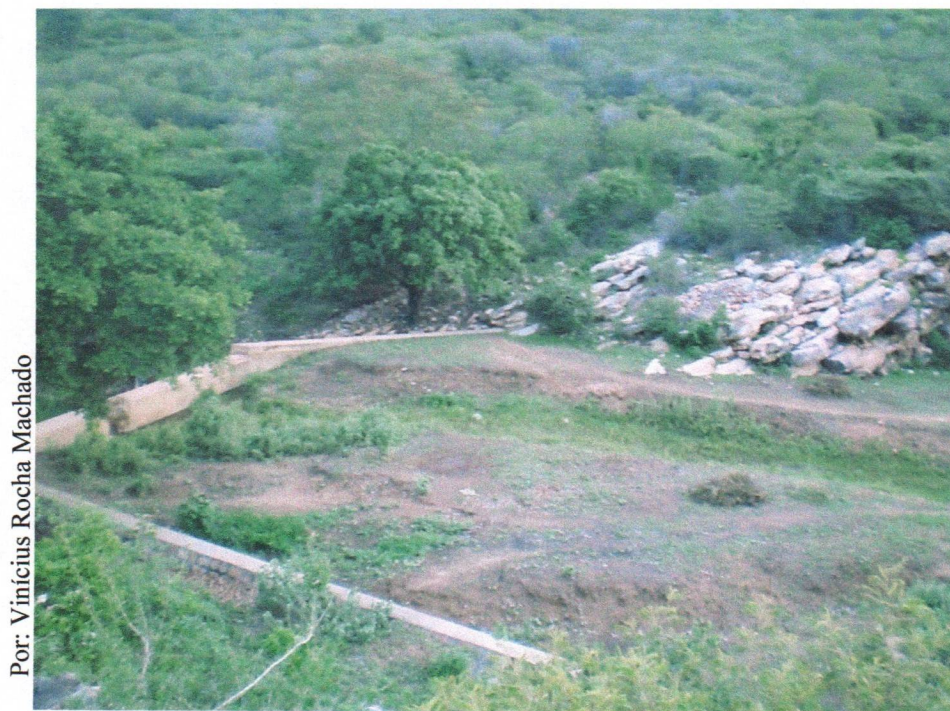
Foto 18 – Vista da barragem assoreada e entulhada
