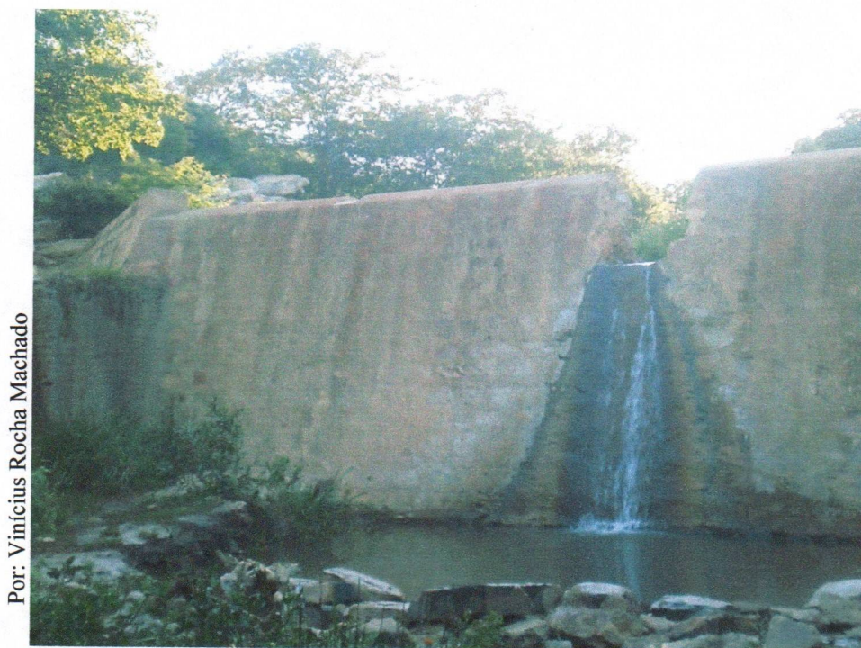
Foto 17 – Vista frontal da barragem
