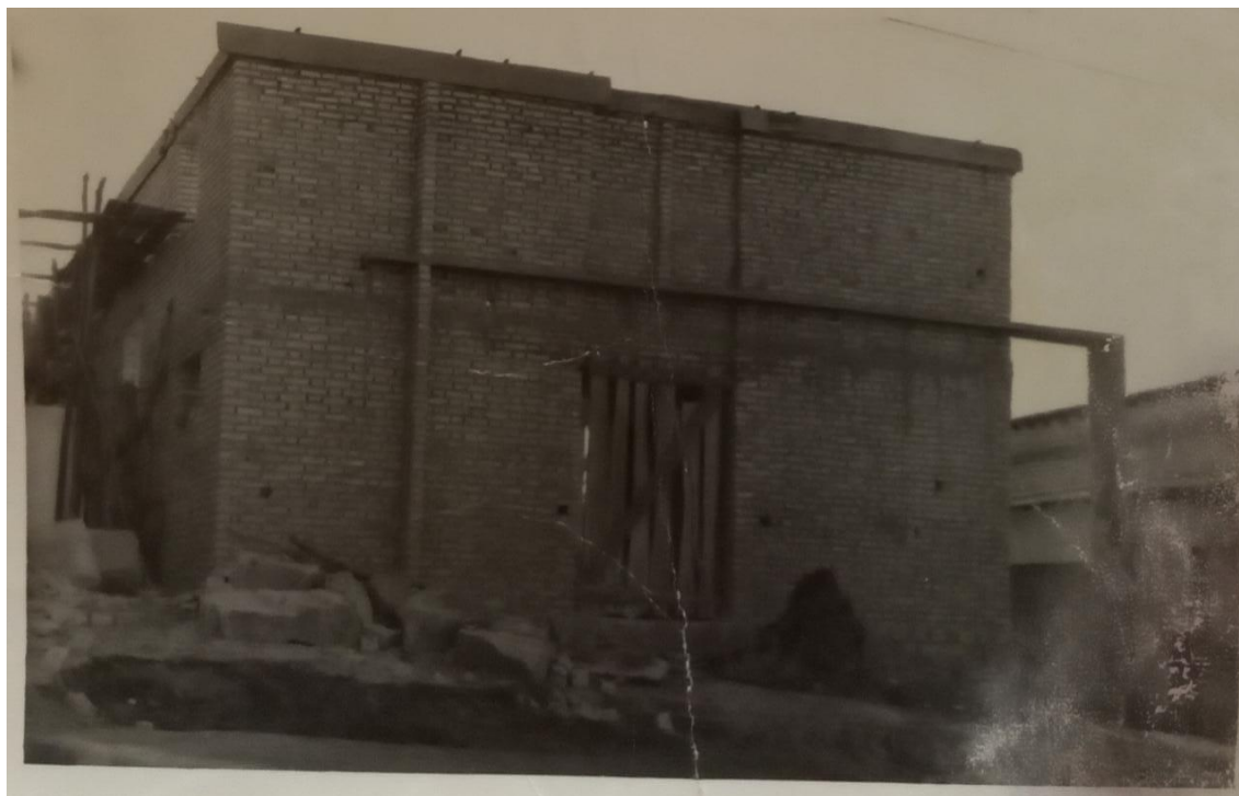
Figura 2: Templo da Igreja Batista de Caetité em construção. Acervo pessoal do fotógrafo Ivo Meira. Autor: Ivo Meira. 1973.
