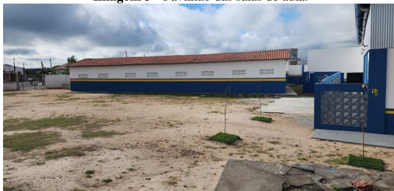
Imagem 3 - Pavilhão das salas de aula.
