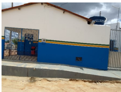
Figura 6: Atual Escola Municipal de Cazumba
