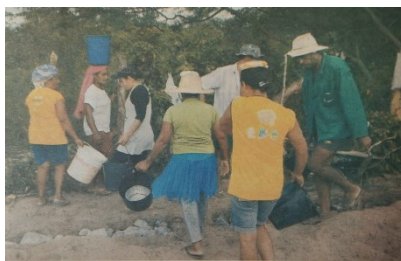
Figura 10: Mutirão para construção pela comunidade.
