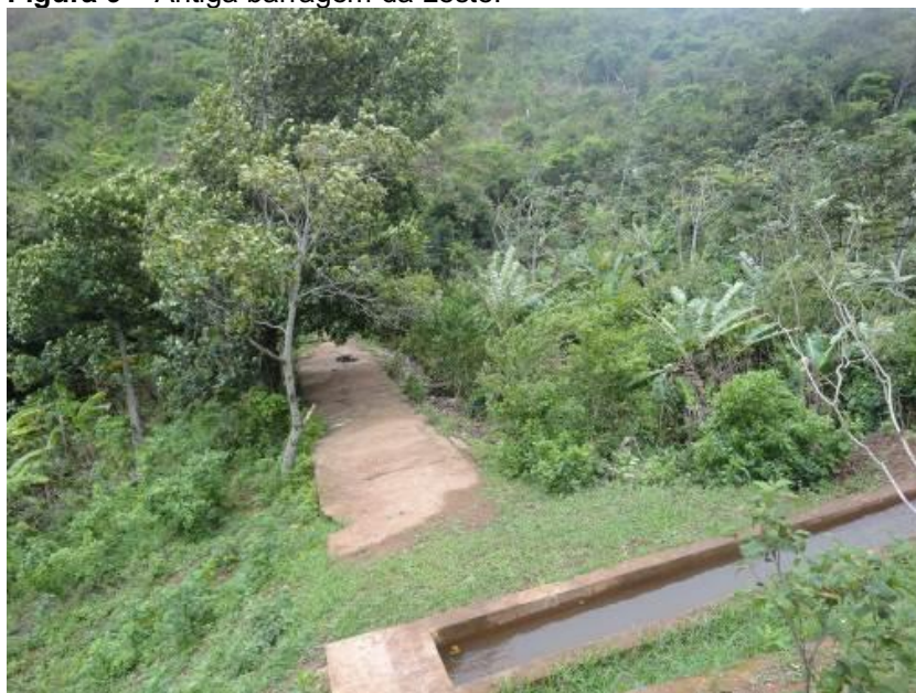
Figura 9 – Antiga barragem da Leste.
