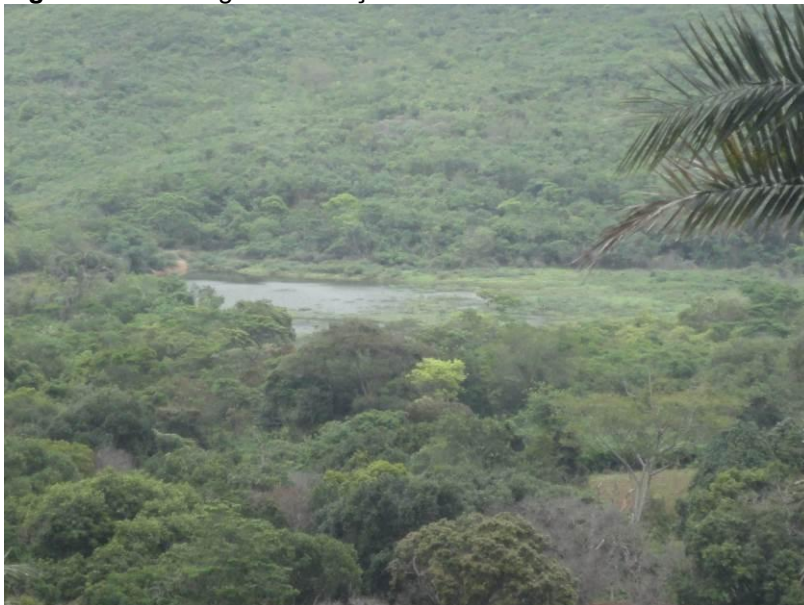
Figura 11 – Barragem da Suíça.
