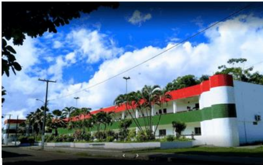
Figura 2 – Visão externa do Pavilhão 1
