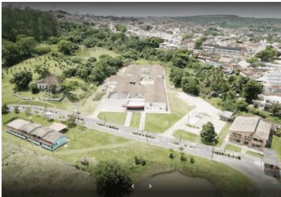
Figura 3 – Visão aérea do Pavilhão 2
