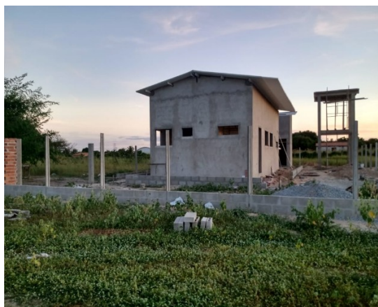
Figura 5 - Construção da agroindústria
