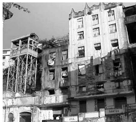
Elevador Hidráulico e prédios que servem de cortiço. Foto de arquivo do Professor Eduardo Neira Alva.
