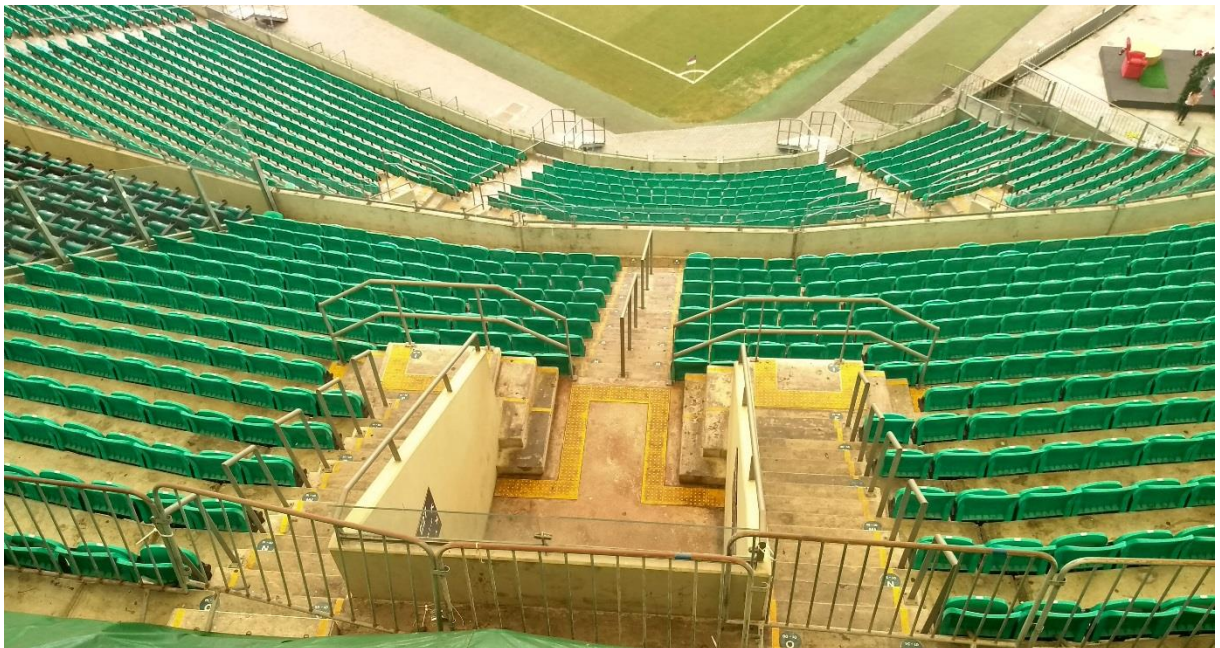
Figura 7 – Piso tátil na arquibancada e corrimão
