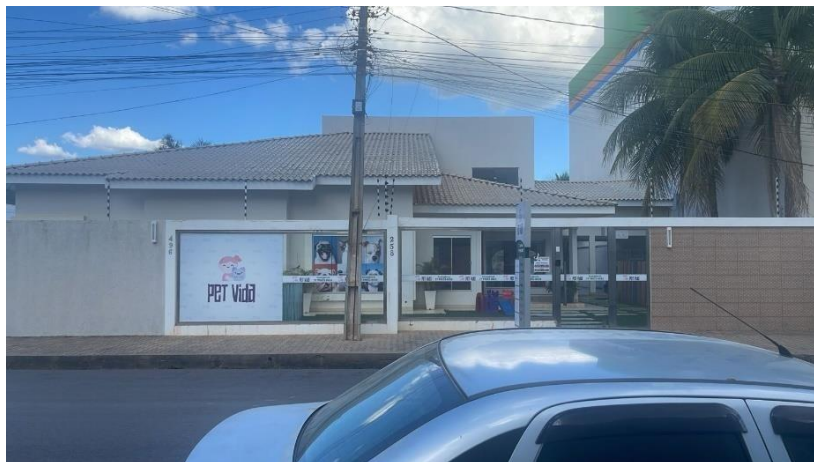
Figura 1: Fachada frontal da clínica
