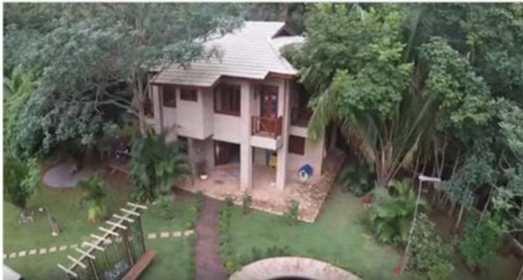
Figura 7 – Residência correspondente à área da figura 8
