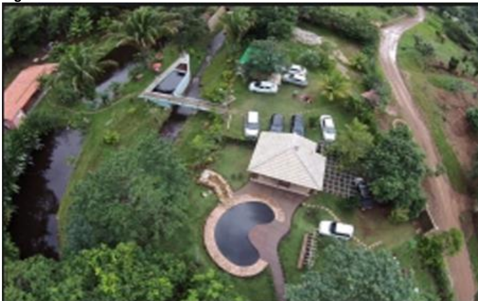
Figura 8 – Residência construída diretamente no curso do rio Coxo de Dentro
