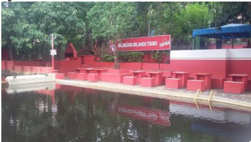
Figura 11 – Balneário Orlando Touro construído diretamente sob o curso do rio
