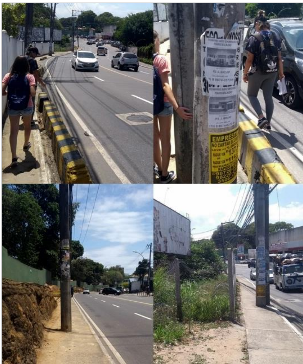
Foto 1: Precariedade das calçadas na Rua Silveira Martins.
