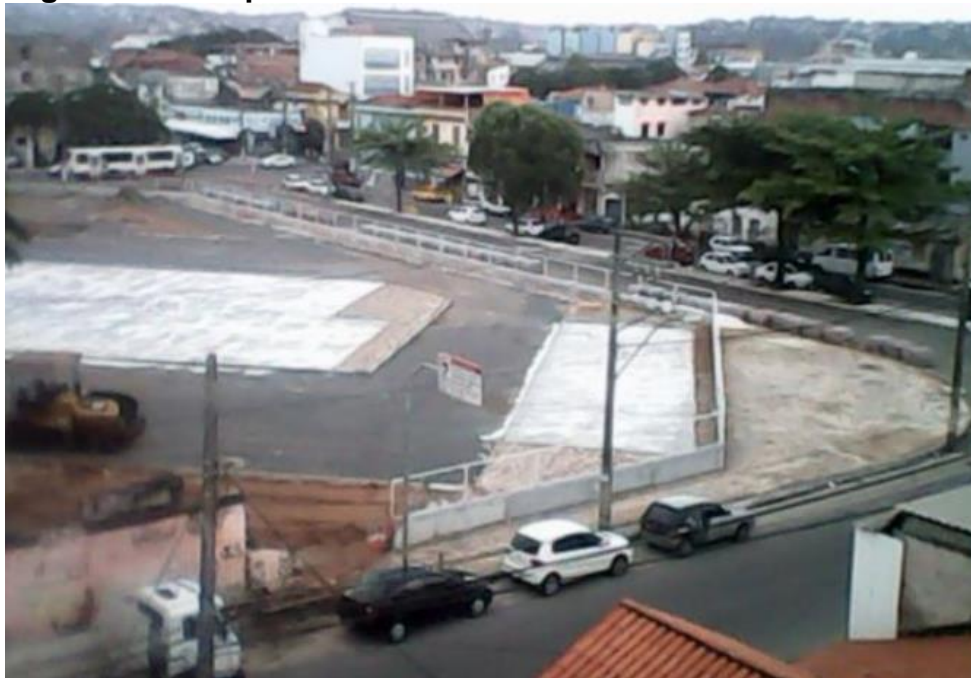
Figura 25: Complexo demolido dando forma ao estacionamento
