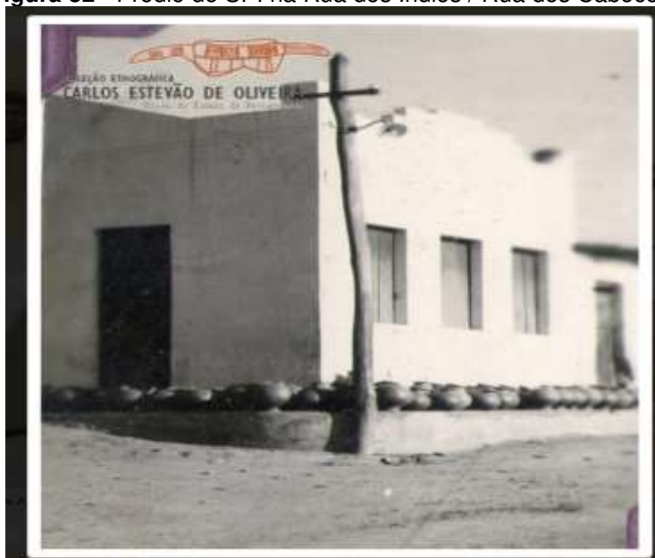
Figura 32 - Prédio do SPI na Rua dos Índios / Rua dos Cabocos.
