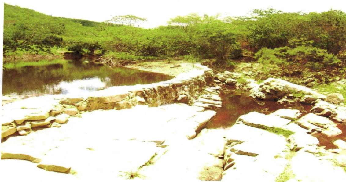
Figura 8: Barragem de Netão Por: Napoleão Neto, março de 2009.
