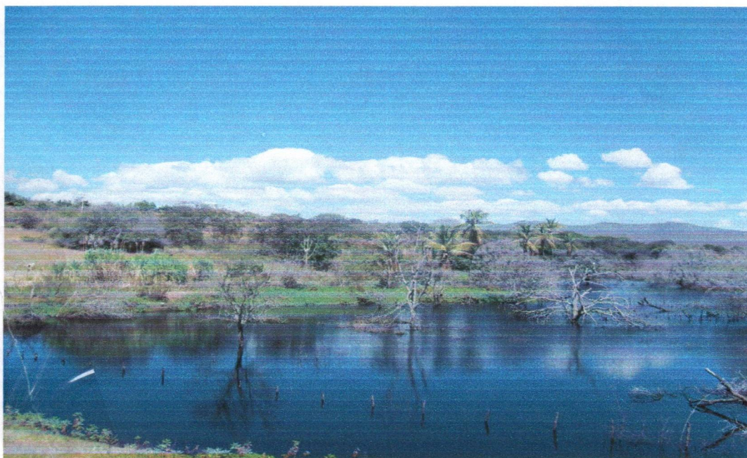
Figura 13: Água represada na Barragem de argamassa em S. Bento de Cima.
