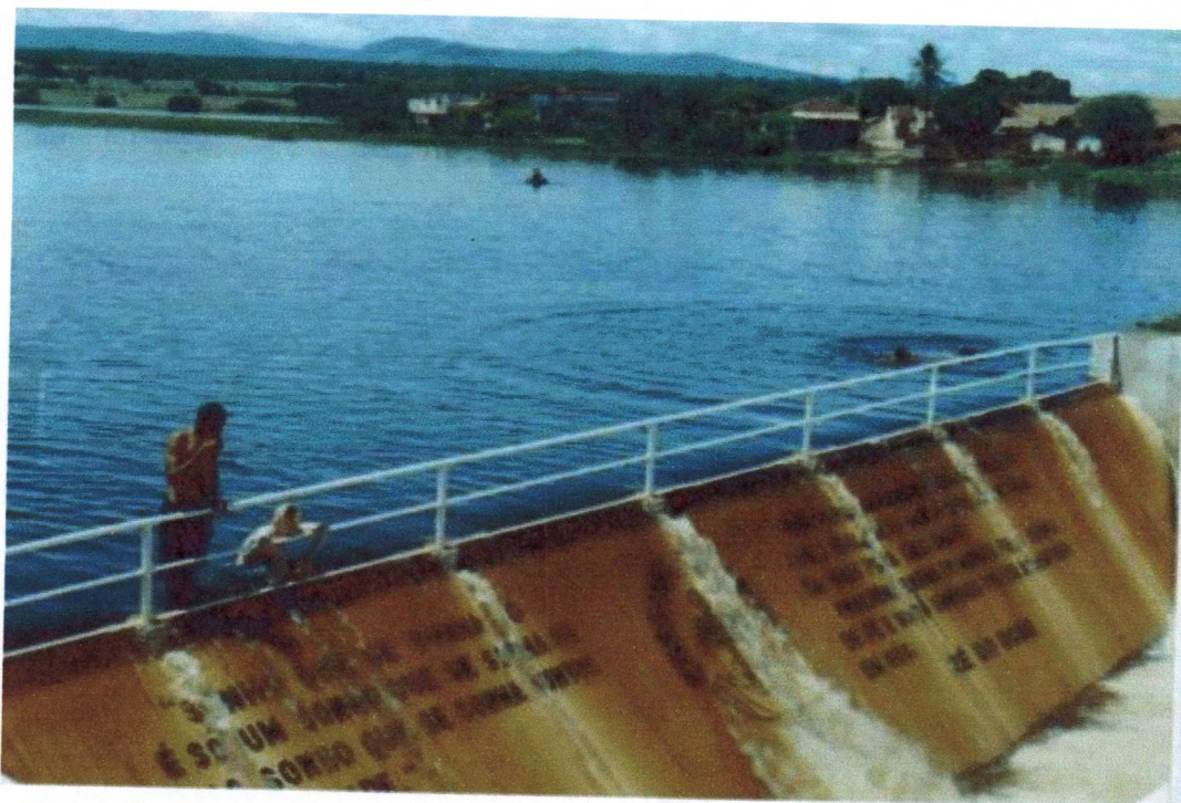
Figura 10.: Barragem de Barra do Mendes. Por: Adriano Barreto, fevereiro de 2002.
