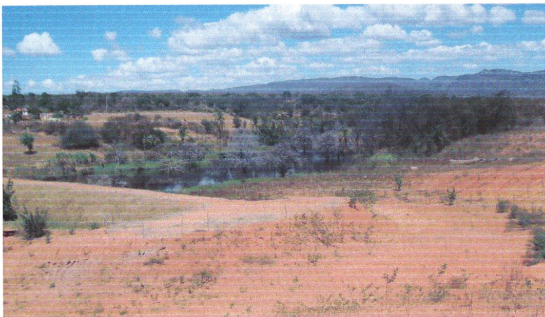
Figura 16: Erosão na margem direita da barragem. Por: Napoleão Neto, agosto de 2008.
