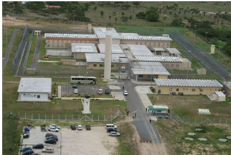
Figura 4 - Vista aérea do Conjunto Penal de Serrinha
