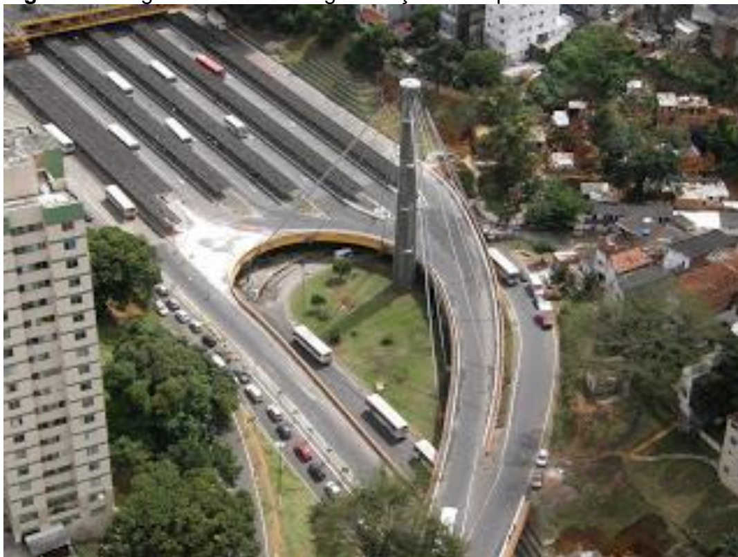
Figura 1: Imagem Aérea da Antiga Estação da Lapa.
