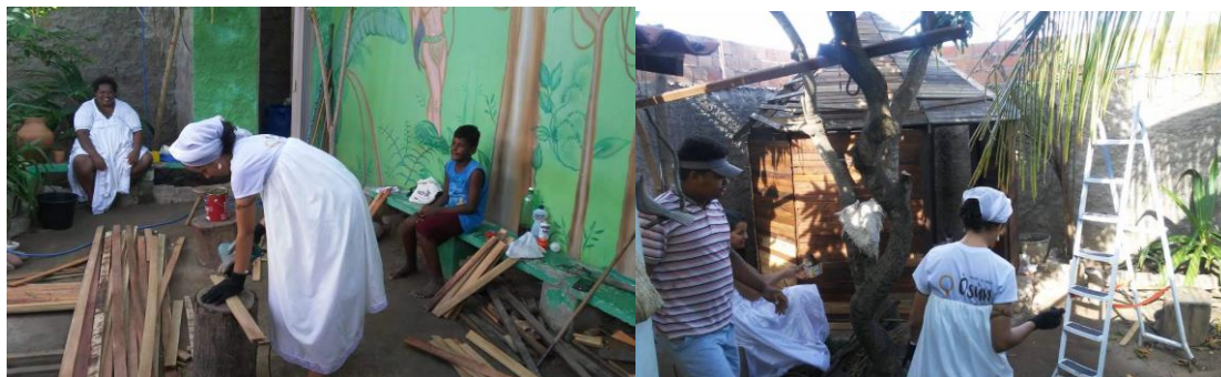
Figura 6: Imagens da última reforma realizada na Oca da Jurema. Fonte: arquivo pessoal da autora, 2020.
