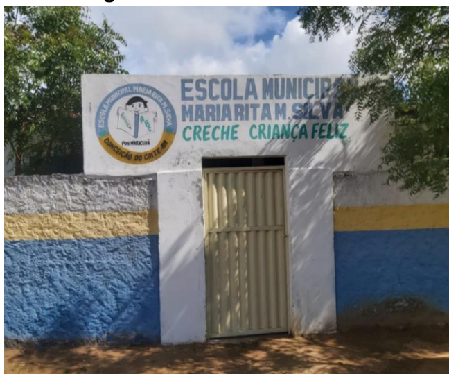
Figura 6 – Fachada da Escola
