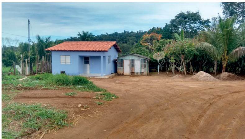
Figura 7 – No primeiro plano, residência construída no âmbito do PNHR, ao lado antiga casa de madeira coberta com telhas de amianto
